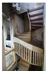
Εικ. 4.2.24. Ενότητα Γ. Αποκατάσταση κλιμακοστασίου με διατήρηση αυθεντικού υλικού
