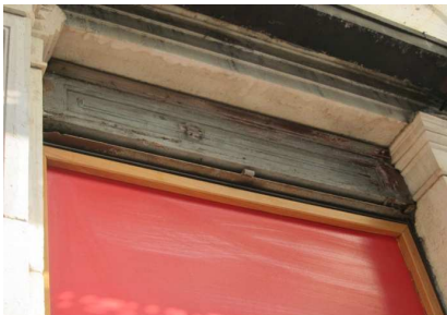
†.6.3. Διακρίνεται το παλαιότερο ρολό εγκιβωτισμένο στις νεώτερες επεμβάσεις.
