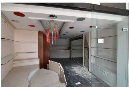
Εικ. 4.2.5. Ι-5. Καθαίρεση νεώτερου παταριού και λοιπών ασύμβατων προσθηκών.
