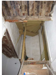
Εικ. 4.3.4. Υ-2. Προτείνεται η αποκατάσταση της επικοινωνίας του χώρου με την αίθουσα πολλαπλών χρήσεων μέσω της κλίμακας ανόδου και την διάνοιξη της θύρας. Τα ξύλινα στοιχεία της οροφής και της κλίμακας προτείνεται να αποκατασταθούν με διατήρηση του αυθεντικού υλικού.
