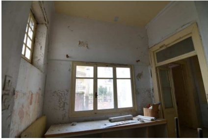
Εικ. 4.4.5. Άποψη του χώρου A-3. Το άνοιγμα στα αριστερά προτείνεται να φραχτεί και στο κέντρο να τροποποιηθεί με την προσθήκη νέου κουφώματος.
