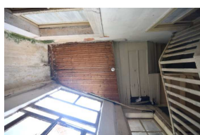
Εικ. 4.2.21. Ενότητα Γ, χώρος I-10. Καθαίρεση προσθηκών και αποκατάσταση ξύλινης οροφής στην αρχική της μορφή.
