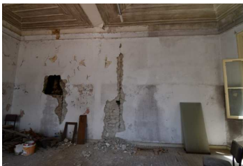
Εικ. 4.4.7. Άποψη των φραγμένων τζακιών του χώρου A-12 τα οποία προτείνεται να μετατραπούν σε ρηχές κόγχες ώστε να γίνεται υπόμνηση της παλιάς τους λειτουργίας.
