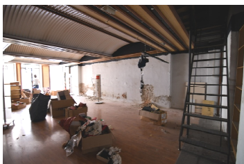
Εικ. 4.2.5. Ι-5. Καθαίρεση νεώτερου παταριού και λοιπών ασύμβατων προσθηκών.
