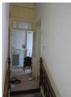
Εικ. 4.4.4. Άποψη της εισόδου στον όροφο. Στα δεξιά η θύρα που προτείνεται να φραχθεί για στατικούς λόγους.
