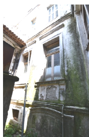
Εικ. 4.3.2. Η ίδια θύρα από τον ακάλυπτο 1. Προτείνεται επίσης η αποκάλυψη και συντήρηση των λίθινων βαθμίδων που οδηγούν στο κατώφλι της και στον χώρο Υ-2.
