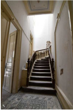
Εικ. 4.2.9. Φραγμένο άνοιγμα κλιμακοστασίου. Προτείνεται η διάνοιξη του για την σύνδεση με τον χώρο πολλαπλών χρήσεων και την πρόσβαση Α.Μ.Κ μέσω αναβατορίου.
