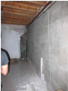
Εικ. 4.3.3. Ο τοίχος από τσιμεντόπλινθους για την αντιμετώπιση της υγρασίας στον χώρο Υ-7. Προτείνεται η καθαίρεσή του, με ταυτόχρονες εργασίες αποστράγγισης στον όμορο επιχωμένο χώρο κάτω από τον κεντρικό διάδρομο Ι-1.
