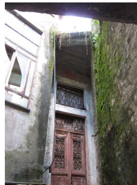
ικ. 4.4.10. Άποψη του προβόλου από οπλισμένο σκυρόδεμα στη συνέχεια της βεράντας, πάνω από τη φραγμένη θύρα προς τον ακάλυπτο 2. προτείνεται η καθαίρεσή του και η κατασκευή μεταλλικού στεγάστρου.
