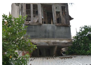
Εικ. 4.2.22. Ενότητα Γ. Απαιτείται διερεύνηση του φραγμένου με οπτοπλινθοδομή χώρου βόρεια των αιθουσών I-11 και I-12
