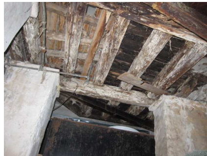
Εικ. 4.3.4. Υ-2. Προτείνεται η αποκατάσταση της επικοινωνίας του χώρου με την αίθουσα πολλαπλών χρήσεων μέσω της κλίμακας ανόδου και την διάνοιξη της θύρας. Τα ξύλινα στοιχεία της οροφής και της κλίμακας προτείνεται να αποκατασταθούν με διατήρηση του αυθεντικού υλικού.
