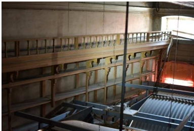
Εικ. 4.2.11. Το ανώτερο τμήμα των περιμετρικών ραφιών του παλαιού καταστήματος. Προτείνεται να αποκατασταθούν στην αρχική τους μορφή με συμπλήρωση των χαμηλών τμημάτων των ορθοστατών.
