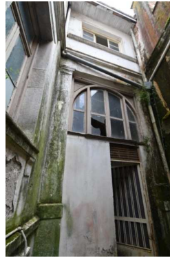
ικ. 4.2.10. Το φραγμένο τοξωτό άνοιγμα το οποίο προτείνεται να αποκατασταθεί στην αρχική του μορφή.
