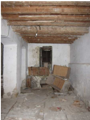
Εικ. 4.3.5. Υ-3. Προτείνεται η αποκατάσταση του χώρου με διατήρηση του αυθεντικού υλικού της οροφής και των δαπέδων.
