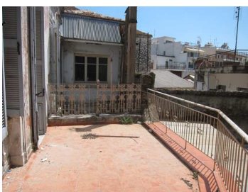
Εικ. 4.4.9. Άποψη της βεράντας. Στα δεξιά διακρίνονται τα νεώτερα κάγκελα, τα οποία θα αφαιρεθούν και θα συνεχιστεί το κτιστό στηθαίο που βρίσκεται εκατέρωθέν τους.
