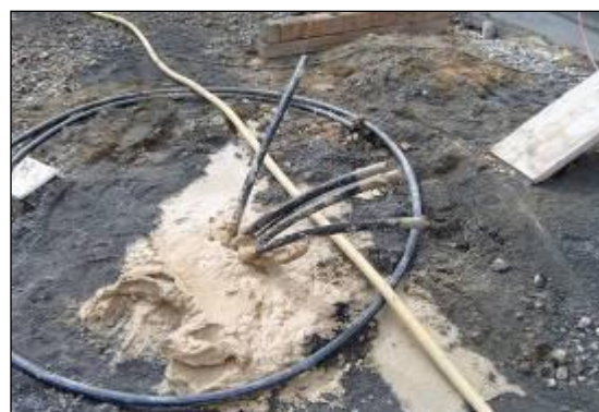
Εικόνα 3.4: Άποψη πληρωμένου με κόνιαμα κατακόρυφου ΓΕΘ διπλού σωλήνα σχήματος “U”
