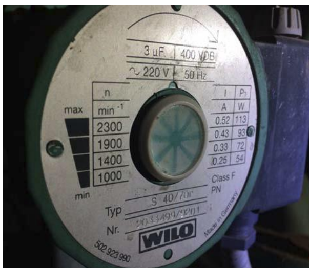
Εικόνα 4.2 Ο κυκλοφορητής στο σύστημα θέρμανσης του κτιρίου
